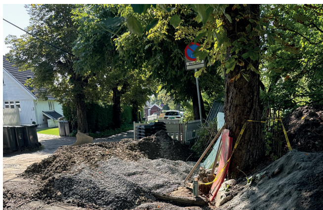
Rotvennlig forsterkningslag under veibane. Blanding av pukk og jord gir gode forhold for rotvekst, samtidig som det fungerer som forsterkningslag for veien. Foto: Jenny Benum Lorange.
