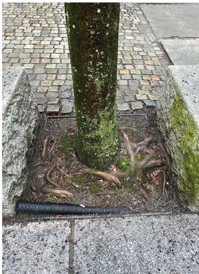
Et altfor lite plantehull har presset røttene opp. Dette treet vil aldri bli stort eller gammelt. Foto: Hanne Johnsrud
