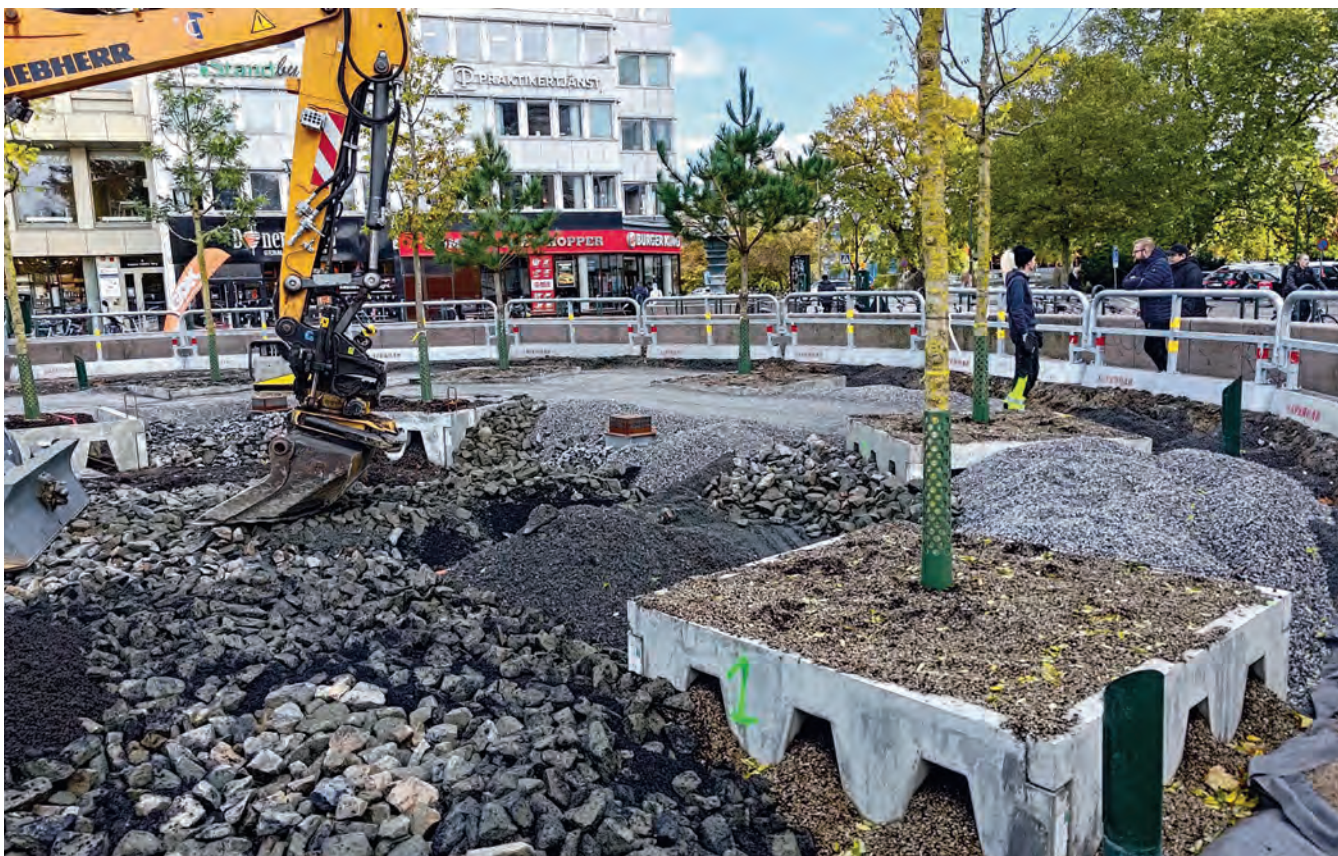
Oppbygging av plantefelt med perforerte plantekasser og skelettjord av pukk og biokull motvirker komprimering. Foto: Johan Östberg, Trekontoret
